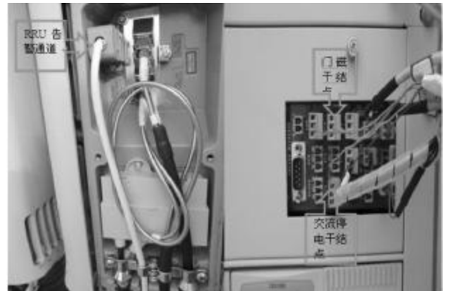
图 4 RRU 与电源柜接线图
